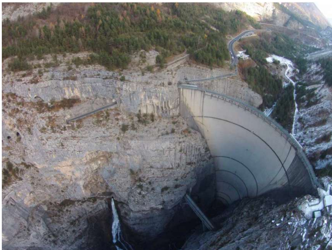
Fotografia 6: Foto aerea al di sopra del coronamento della diga del Vajont. Si notano la viabilità S.P. 251 con le gallerie in roccia, il “Ponte Canale” e lo scarico della galleria di sorpasso con il rilascio dell’acqua de torrente Vajont captata dal “lago residuo C”.
