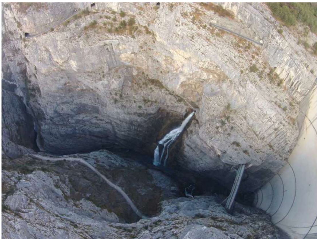
Fotografia 9: Foto aerea della forra del torrente Vajont con al centro la sezione dello scarico della galleria di sorpasso che scarica in alveo la portata naturale del torrente Vajont.
